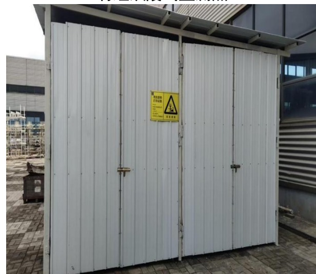
危险废物暂存间②
