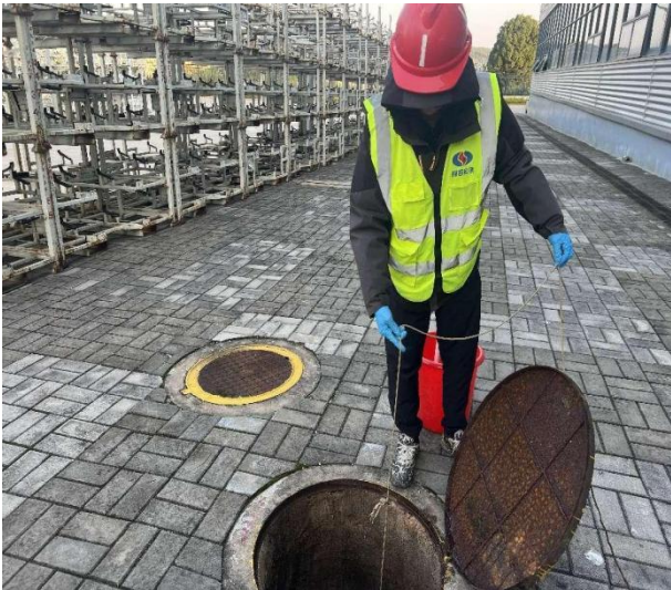
废水排放口及废水监测点
