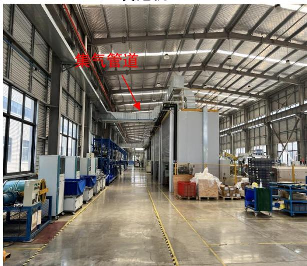
模架（发泡、脱模废气集气管道）
